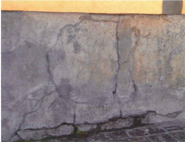
Fontaine Place de la Tillette – fissures multiples le long du bassin
