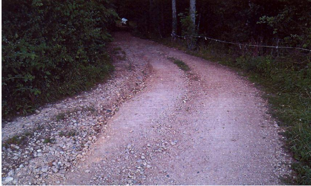
Erosion route gravellée (chemin de la Léchère)
