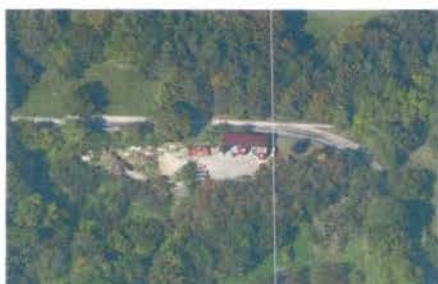
Déchetterie de Bassins
