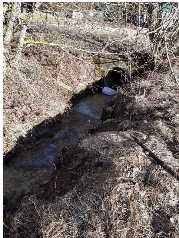
Figure 3 Entrée du ruisseau dans la canalisation
