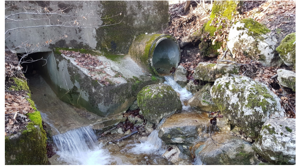
Figure 5 : Sortie sous le pont chemin de la Trappe - route du Sétif
